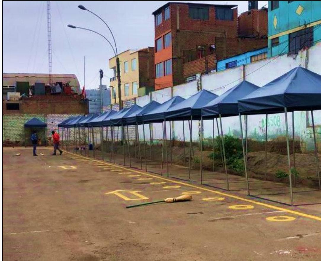
Imagen 01: Instalación de toldos 2m X 2m Fuente: Propia
