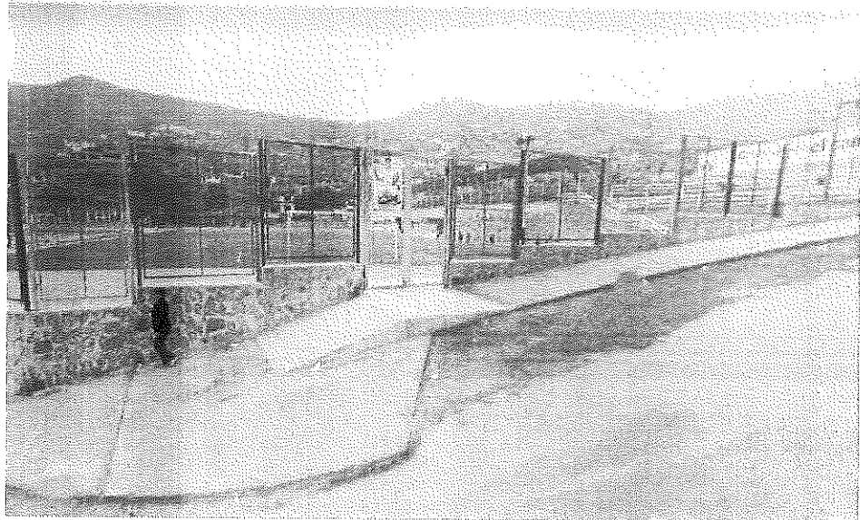
Fotografía 09: Puerta de Evacuación en Jr. 20 Diciembre
